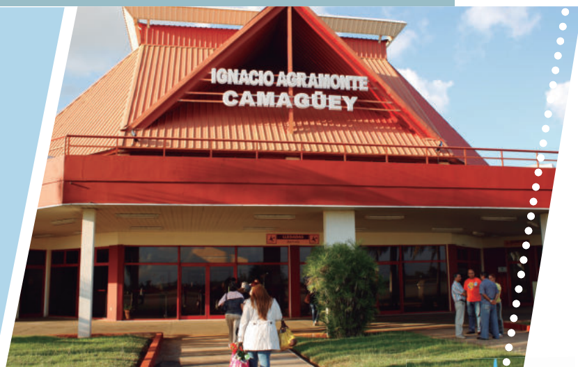
Aeropuerto de Camagüey
